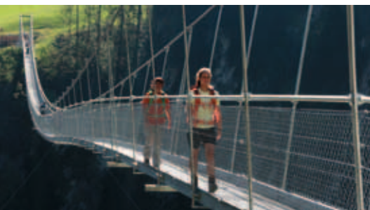
Fußgängerhängebrücke über die Höhenbachschlucht Jöchelspitzbahn
